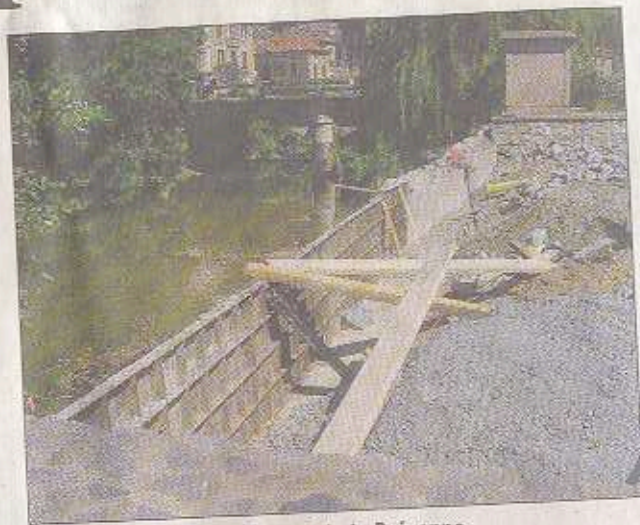
Travaux de réfection du quai de la Brévenne / Photo Pierre Dufresne
